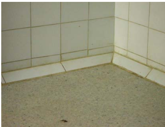
ภาพที่ 7 พื้นห้องของโรงฆ่าสัตว์ที่มีรอยเชื่อมระหว่างพื้นกับผนังเชื่อมสนิทกัน
