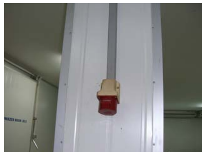
ภาพที่ 27 ติดตั้งสายไฟในท่อติดกับผนังและปลั๊กไฟที่ป้องกันอันตรายจากกระแสไฟฟ้า
