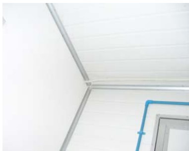
ภาพที่ 27 ติดตั้งสายไฟในท่อติดกับผนังและปลั๊กไฟที่ป้องกันอันตรายจากกระแสไฟฟ้า
