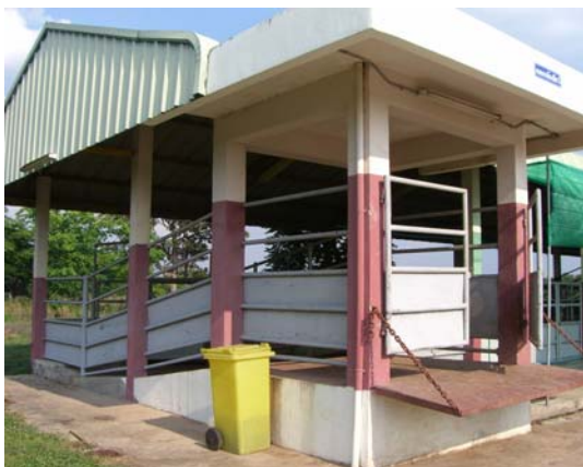
ภาพที่ 3 เทียบให้สุกรลงจากรถขนส่งได้สะดวก
