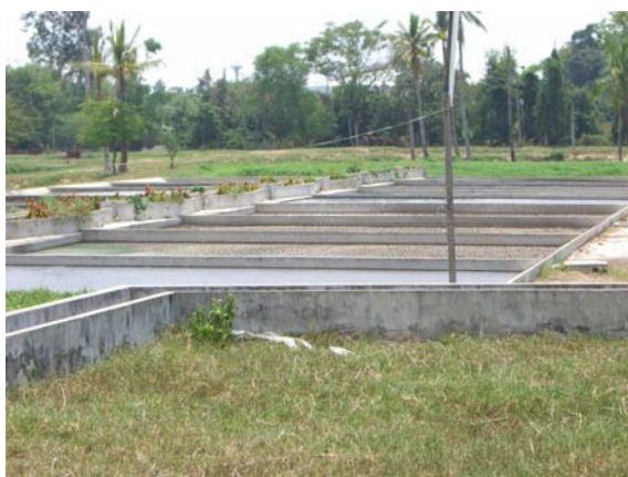
ภาพที่ 22 บ่อบำบัดน้ำเสียจากโรงฆ่าสัตว์
